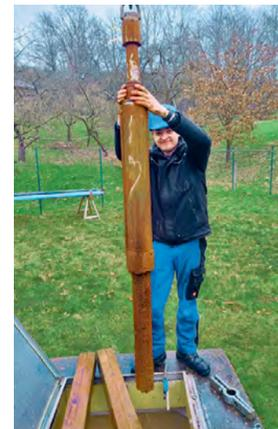
Jacob Geßler demontiert die Pumpe von der Steigleitung, die am Kranhaken hängt.
