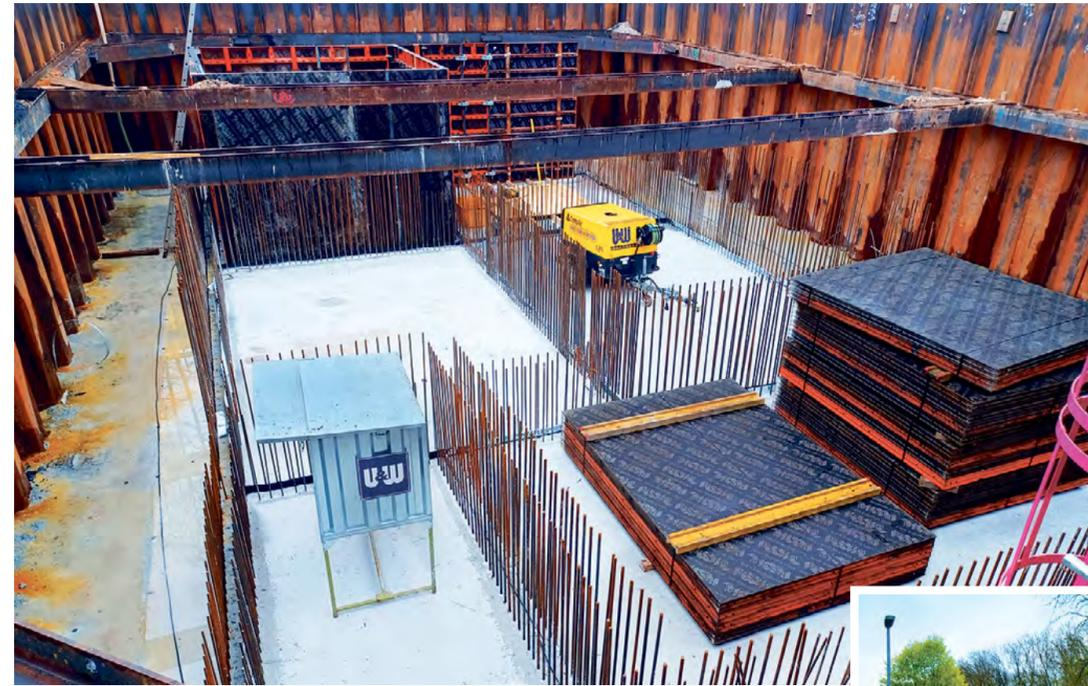
Einblick ins Innere: Hier entsteht das Kompaktbecken der Kläranlage Lippersdorf.
