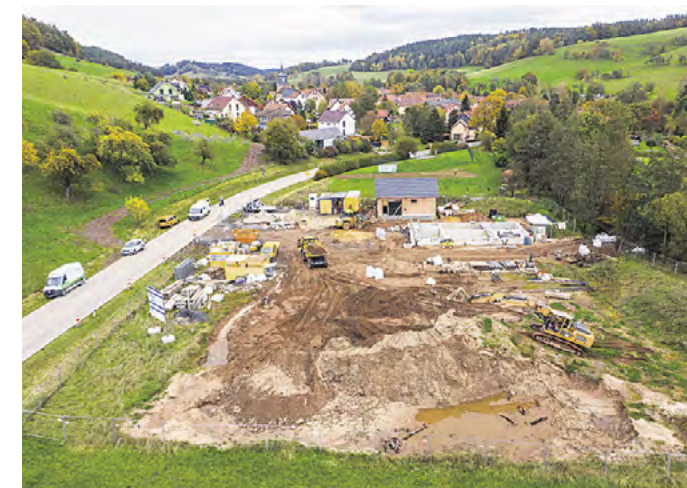
Aus der Vogelperspektive ist der Baufortschritt der neuen Kläranlage Taler I in Lippersdorf deutlich zu erkennen. Foto: Uwe Geißler
